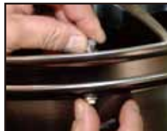
インナーバルブナット 締め付けトルク T=1.5 \pm 10\% \text{N}\cdot\text{m}
